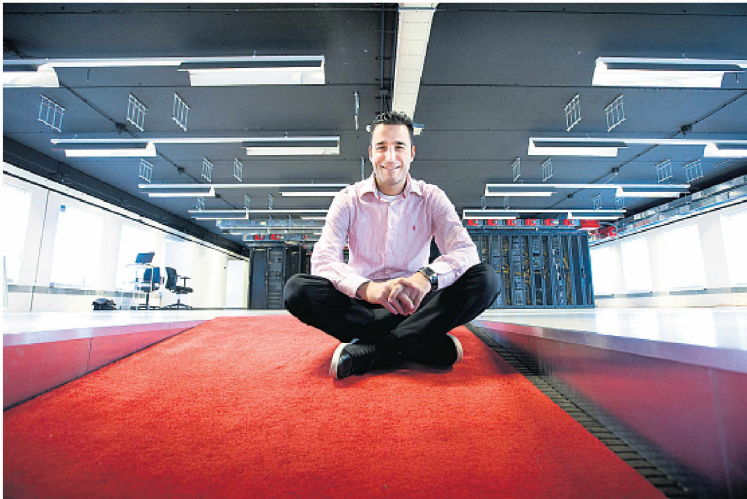
Musti Aslan in het datacentrum van Qweb.
